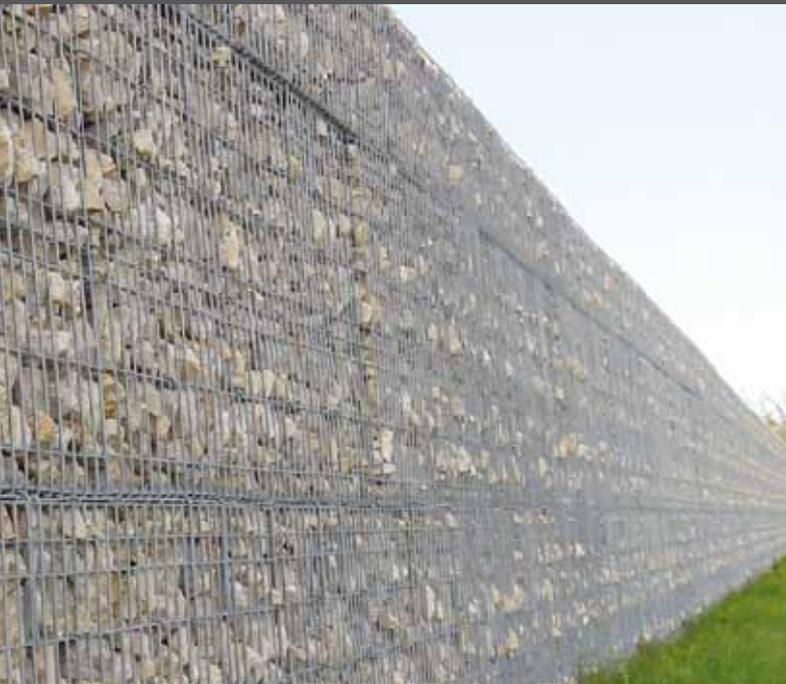
Dämmung des Durchgangsschalls einschließlich der Fugen mindestens 40 dB(A) gemessen nach ZTV-LSW 06 bzw. DIN EN 1793-2.
