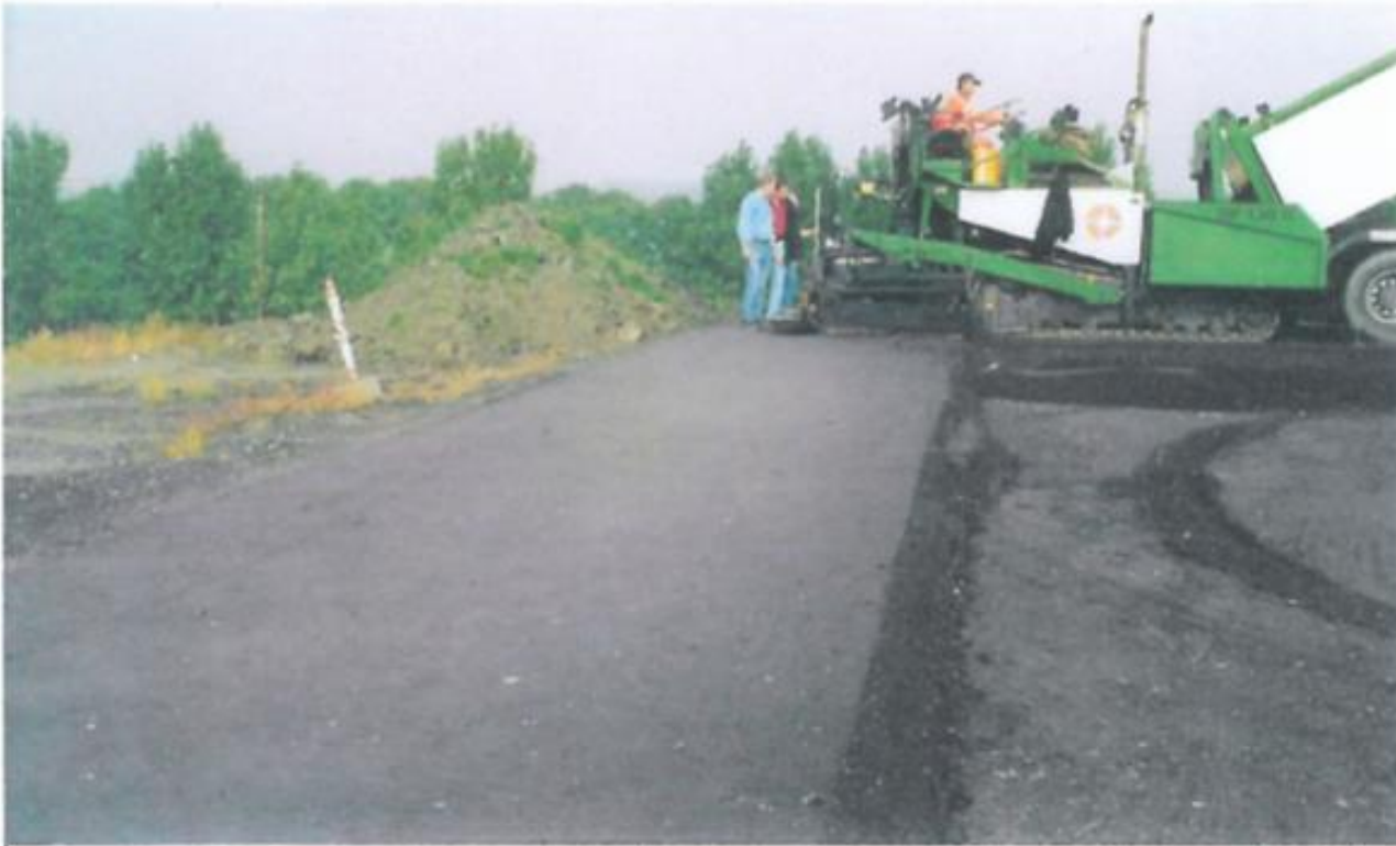
Schaumasphalt aus 100% Recyclingmaterial, Einbau auf der Verladefläche einer Mülldeponie
