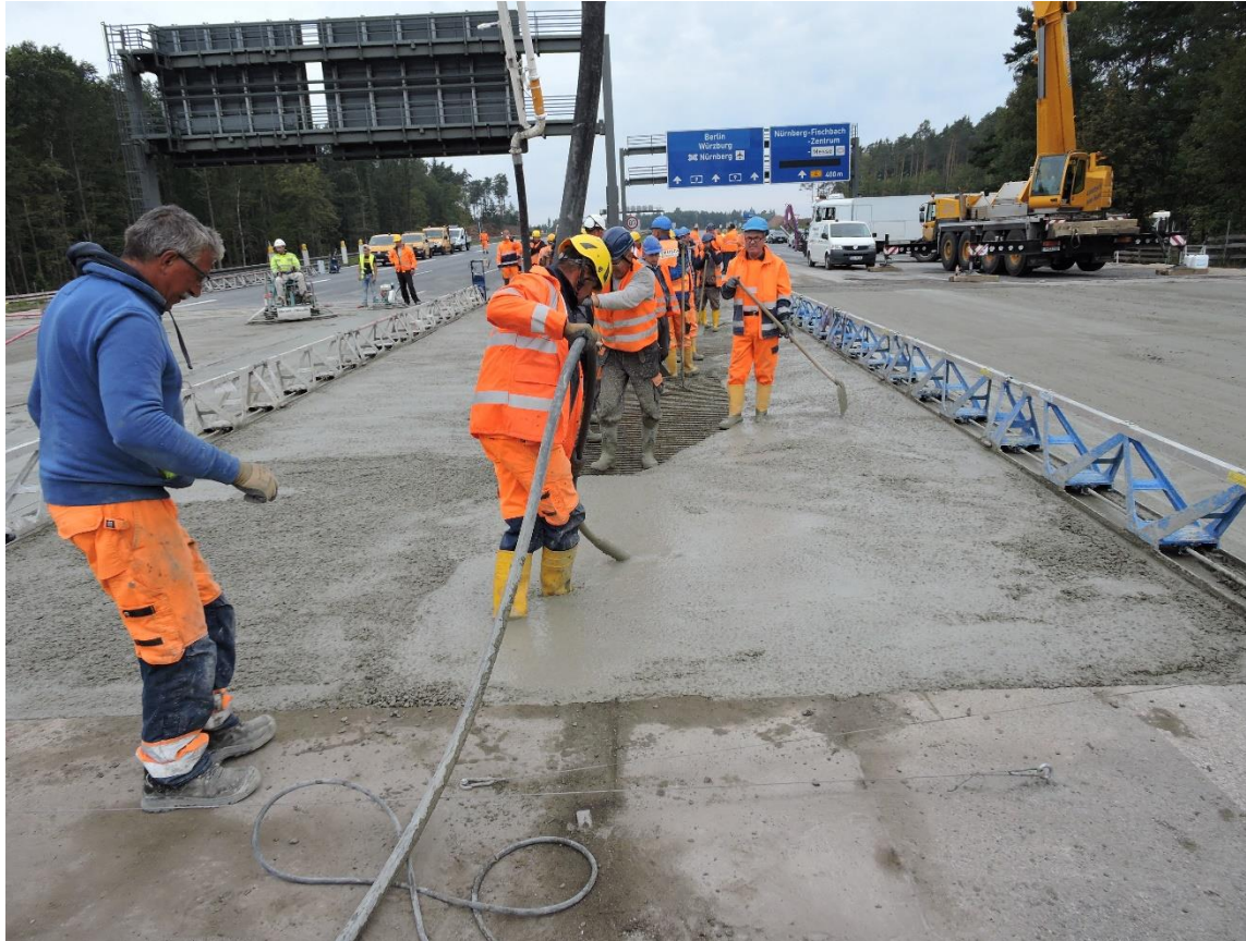
Betoneinbau am Mittelstreifen I
