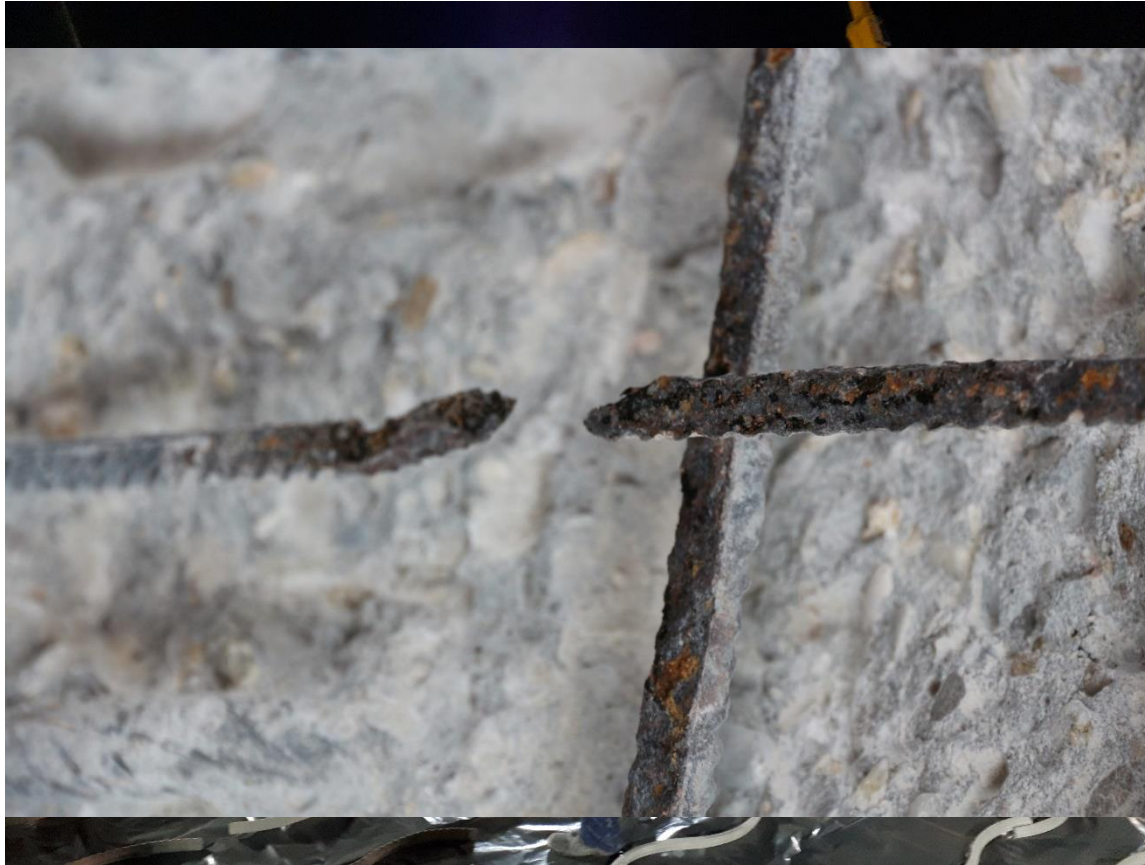
Bewehrungskorrosion III
