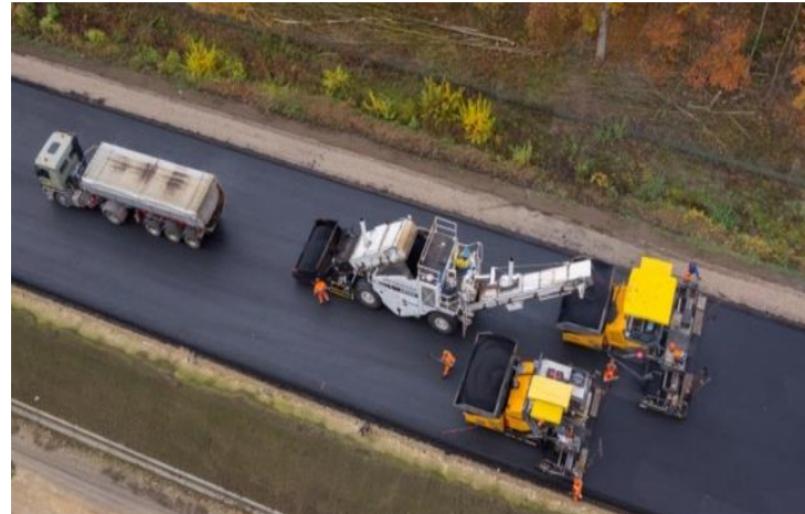
Asphalteinbau B16 bei Ernsgaden
