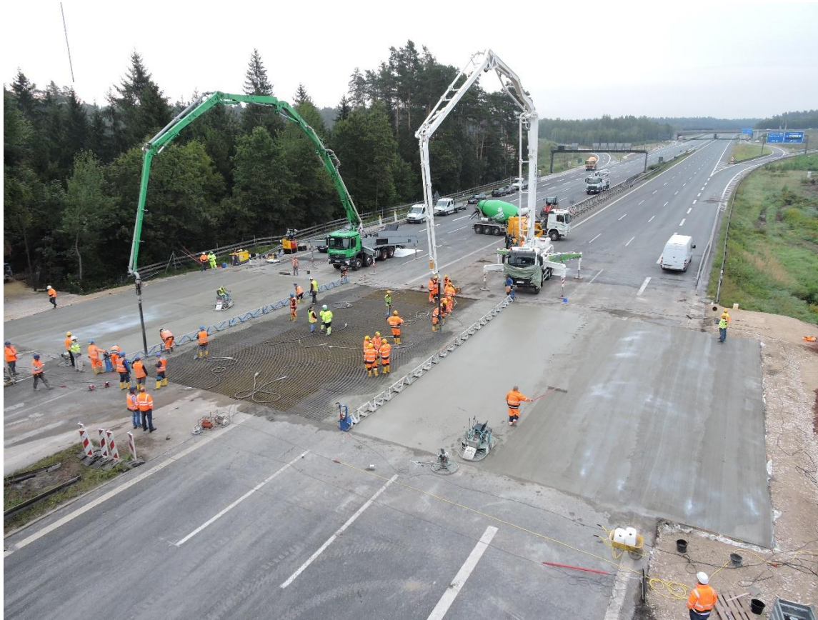
Betonpumpeneinsatz
