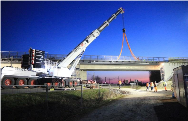
Brückeneinhub bei Zuchering
