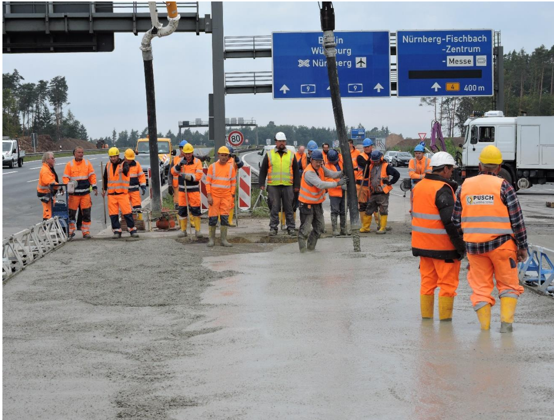
Betoneinbau am Mittelstreifen II
