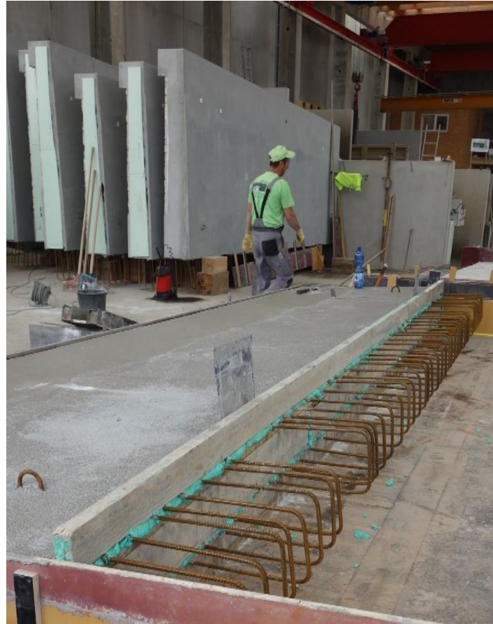
Fertigteilherstellung im Werk
