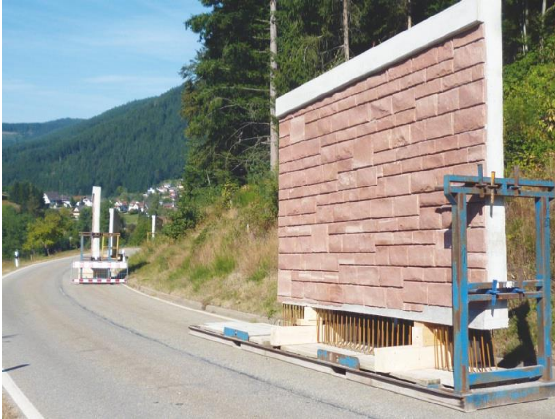
Fertigteil auf der Baustelle
