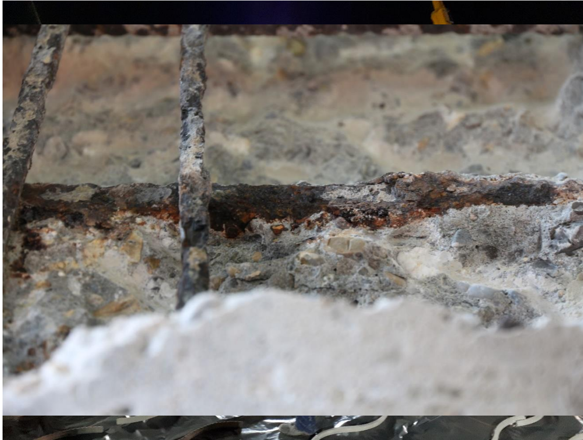
Bewehrungskorrosion II
