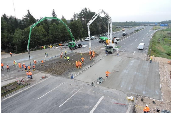
Nachtbaustelle BAB A9, Feucht
