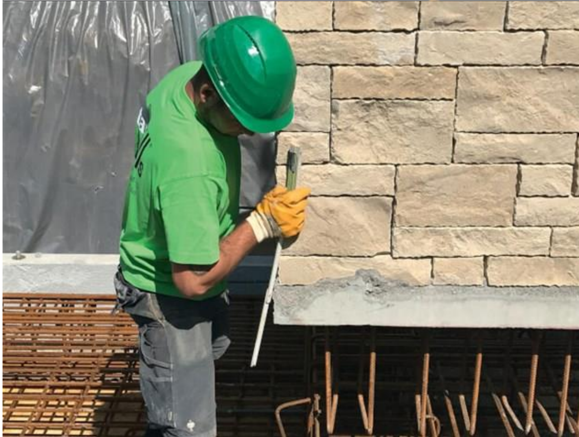
Fertigteileinbau auf der Baustelle
