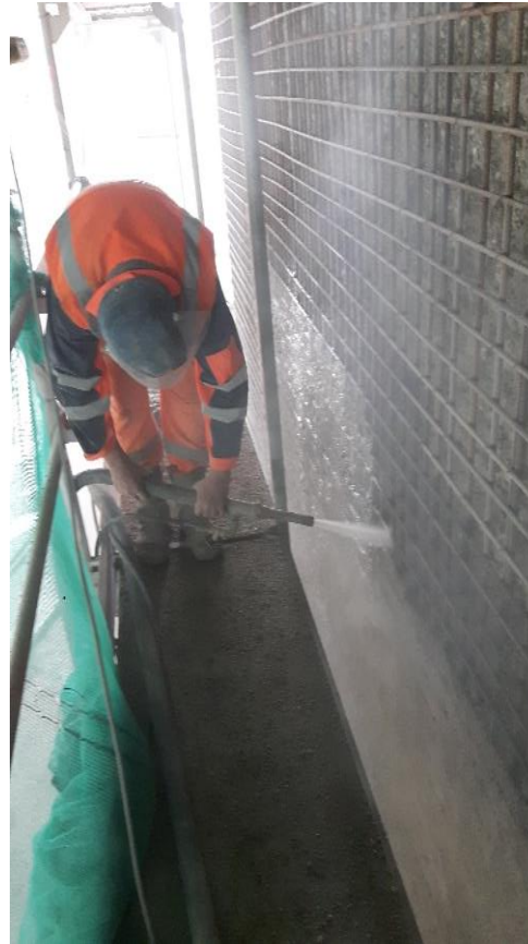
händische Betonspritzarbeiten I
