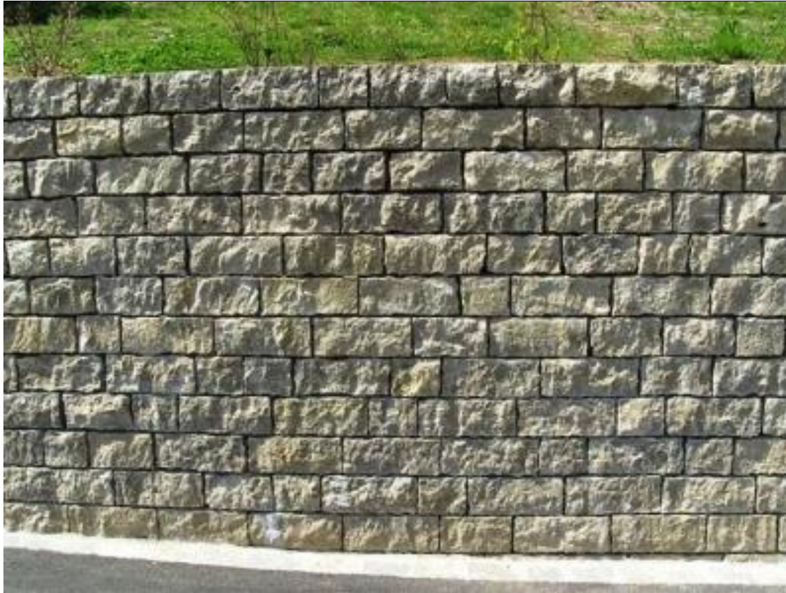
Mauerwerk mit Betonkern
