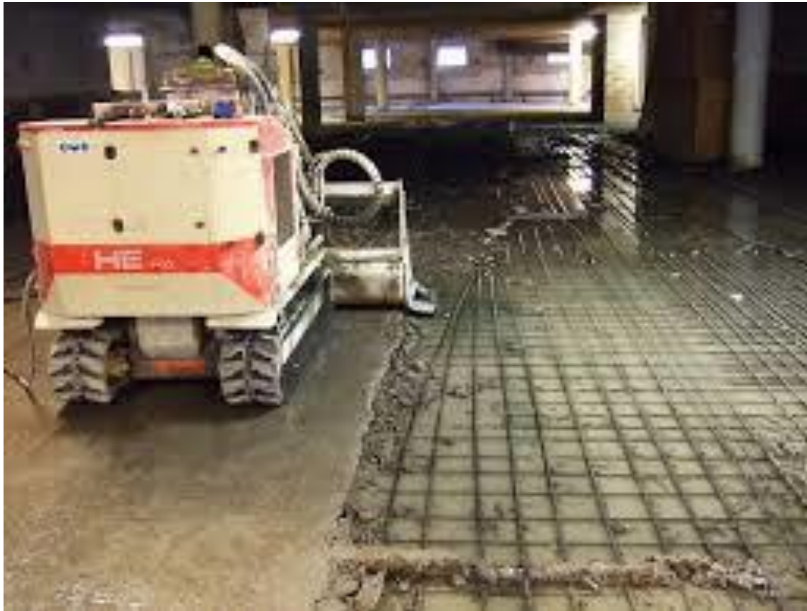
Hochdruckwasserstrahltechnik - Roboter
