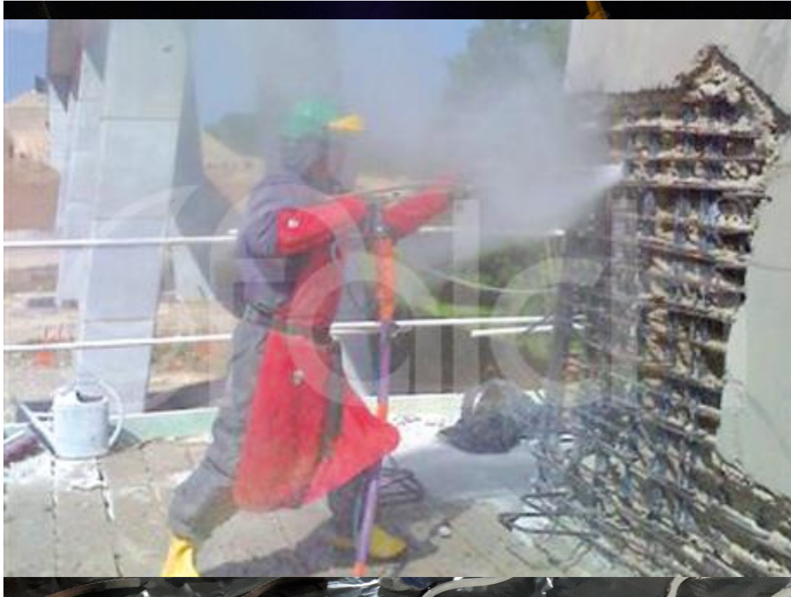
Hochdruckwasserstrahltechnik - Handlanze
