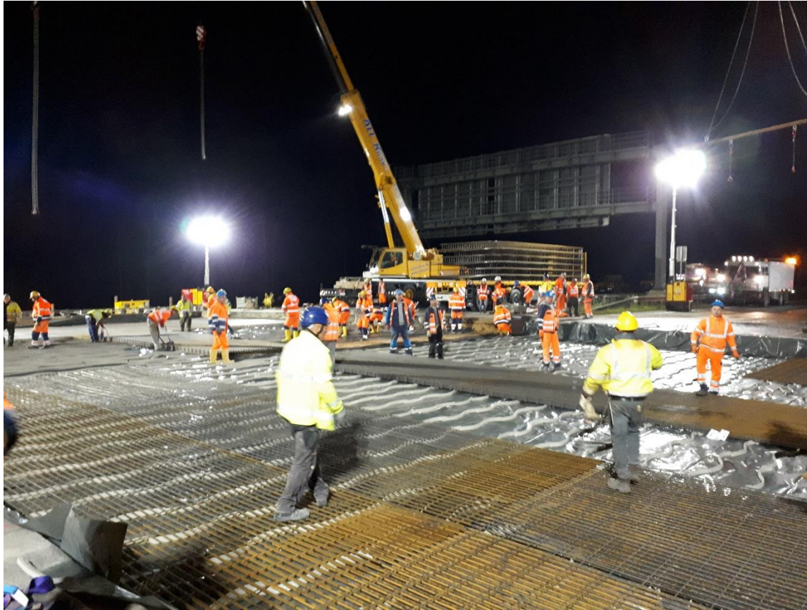
Einbau der Bewehrung
