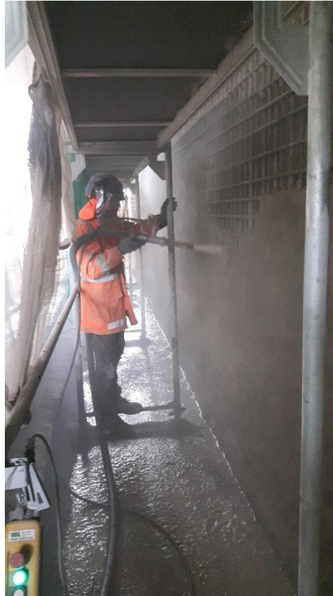
händische Betonspritzarbeiten II
