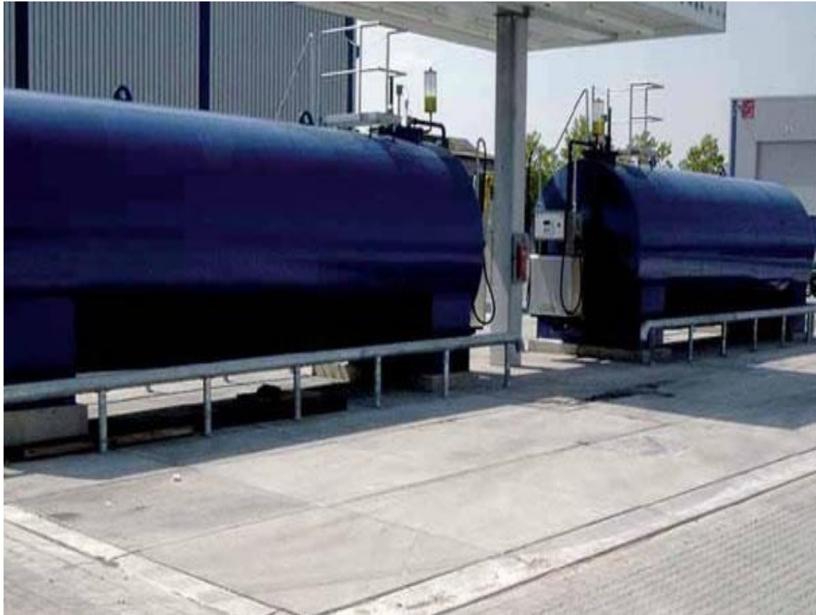
Auffangwanne aus Beton
