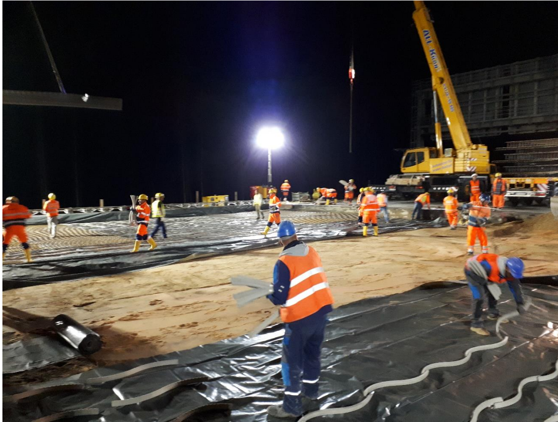
Einbau Trennfolie
