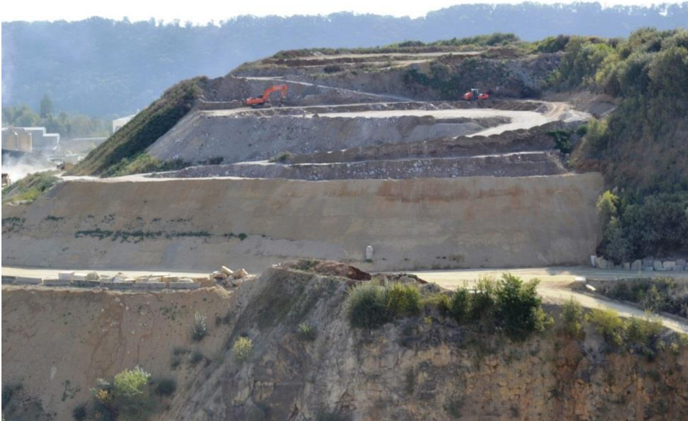
DK 0 Deponie Pfraundorf , Seitenansicht vom hinteren Steinbruch aus
