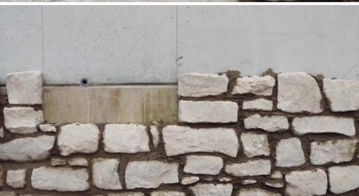
Verkleidung von Betonmauern:
